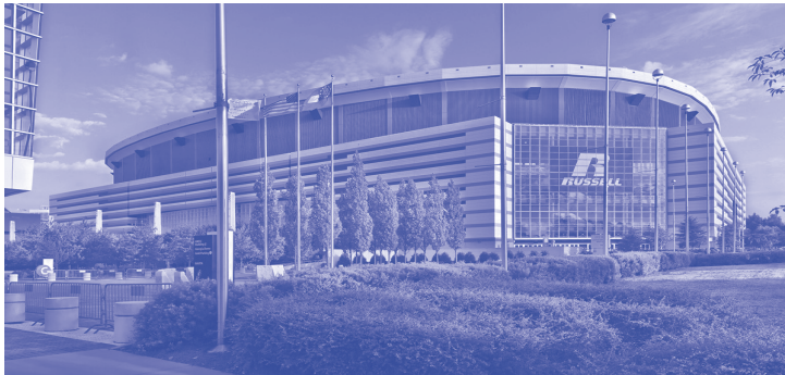
El Georgia Dome
